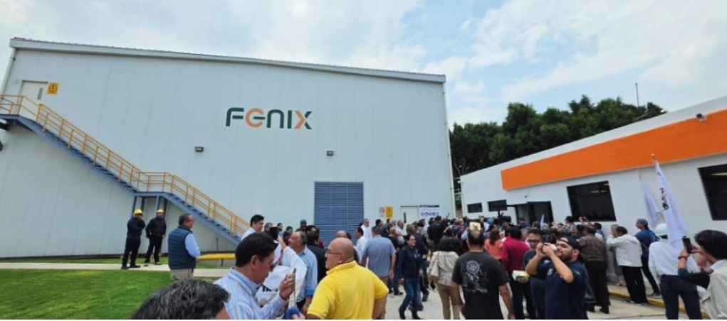
Planta en los antiguos terrenos del SME, en el km 32 de la carretera México-Querétaro
